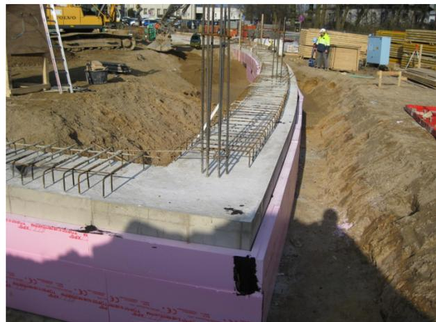
Abbildung 3 Streifenfundament
