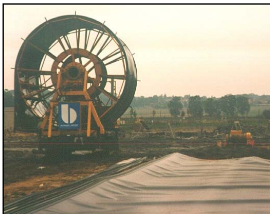
Aufgewickelte und vorbereitete Kunststoffdichtungsbahn
