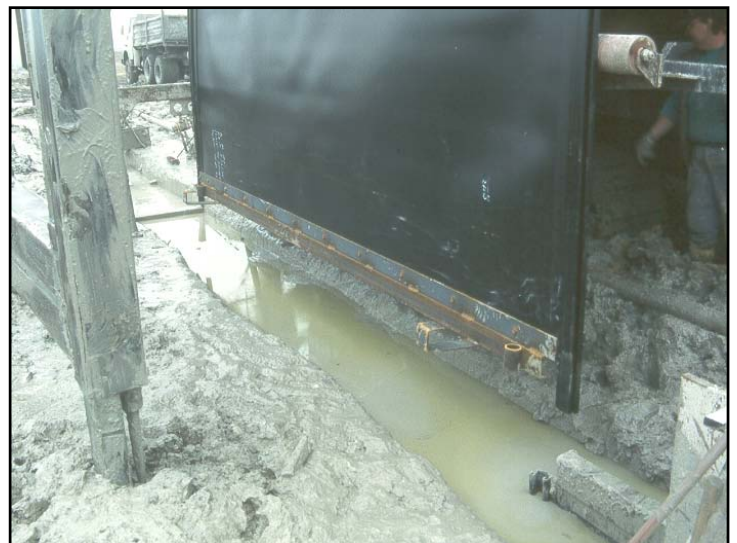
Einsetzen der nächsten Dichtungsbahn
