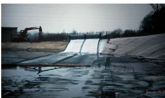
Verlegung des "Kombigrids" (03/1997)
