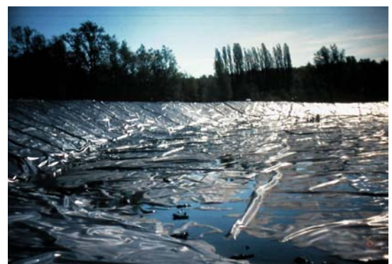
Verlegte Kunststoffdichtungsbahn (04/1997)
