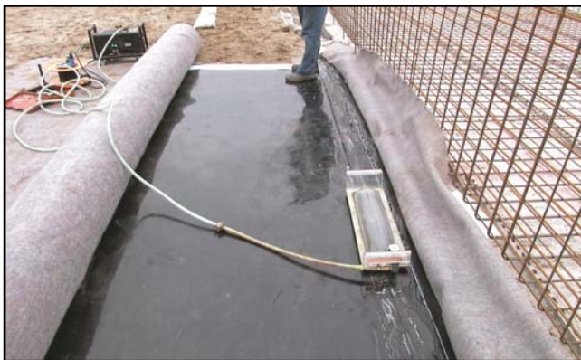
Dichtheitsprüfung einer Anschlussnaht
