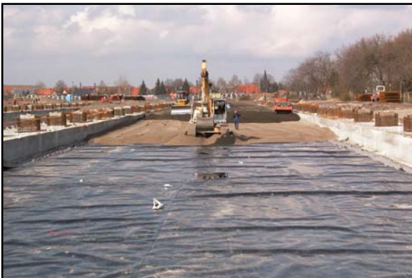
Verfüllung zwischen den Streifenfundamenten, Produktionshalle
