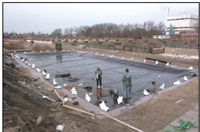
Herstellung einer Abdichtung für ein separates Gebäude
