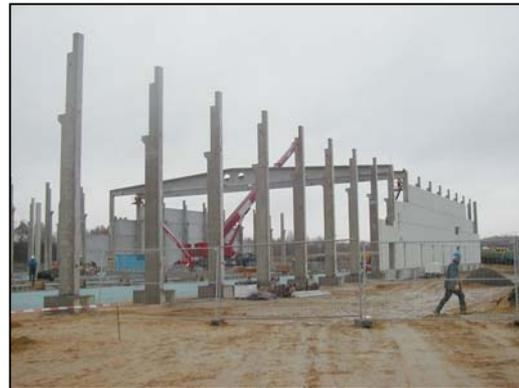
Im Jahr 2004 wurden die Hallen für die nächste Generation der Rotorblätter umgebaut. Dazu wurden ergänzende Kellerbereiche in die bestehenden Hallen eingebunden. Ende 2004 wurde auf dem Nachbargelände eine neue Lackierhalle (etwa 70 m x 30 m) errichtet. Auch hier wurde durch die GGU das Gründungsgutachten erstellt und die grundbautechnische Begleitung der Erdarbeiten durchgeführt.
